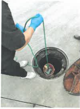
生活污水处理后排放口
